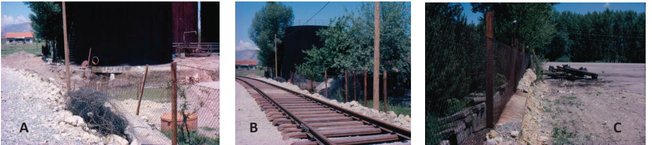
Şekil 4: a) 1989 yılında bindirme türü deformasyon gözlenen yıkılan duvarın lokasyonunun durumu b) Yıkılan duvarın yerine döşenen raylar c) 1989 yılında yıkımdan kurtarılan doğrultu atımın izlenebildiği duvar
